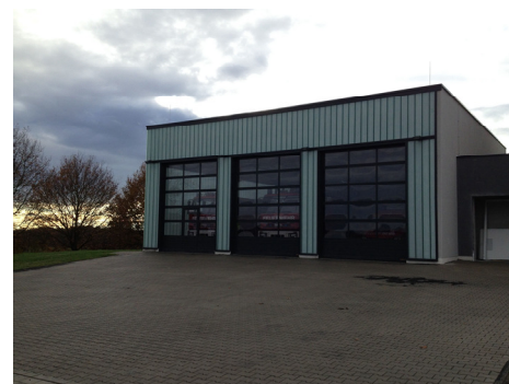
Anbau der Feuerwache Witzhelden
