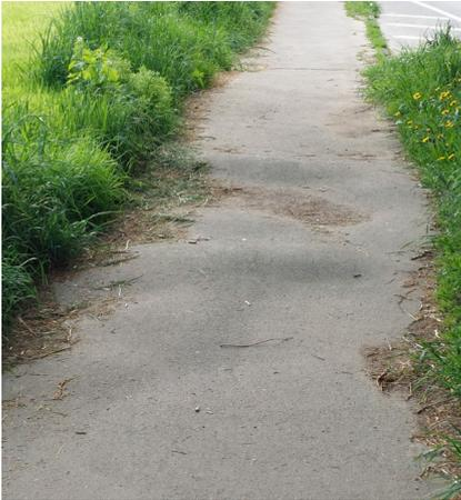
In 2022 fragte die **BWL** bei Stadt Leichlingen an, ein sehr desolates Areal im Fußweg Ortsausgang (Höhe „In den Eichen“) in Richtung Kuhle zu reparieren. Durch das Wurzelwerk der Bepflanzung in der Kanzel hatte die Asphaltdecke große Schäden erlitten. Dieser Fußweg büßte seine Verkehrssicherheit ein: vor allem im Winter gefror das angesammelte Wasser in den vielen Absenkungen. Nun ist der Fußweg durch eine Überbauung wieder für alle sicher.
